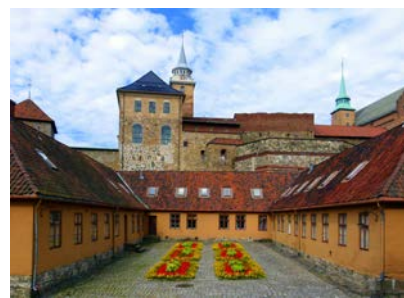
Det sentrale chiffermiljøet i Forsvaret holdt lenge til i bygning 3 på Akershus festning.
